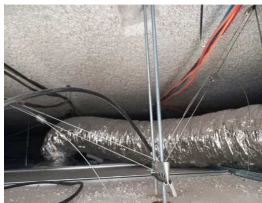
Fixation faux plafond à l'aide de tiges filetées « spitées » dans le béton
